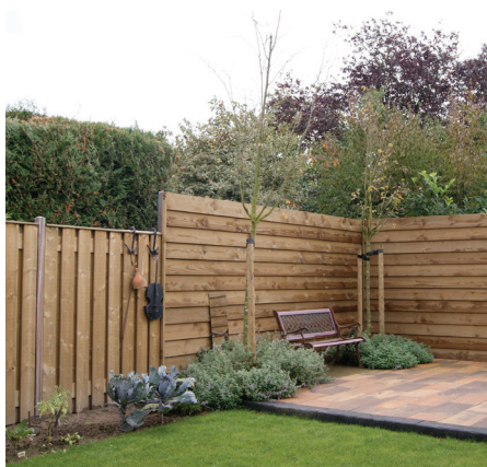
Schutting van Zweedse rabatdelen gemonteerd op regelwerk 2.40 m hoog
