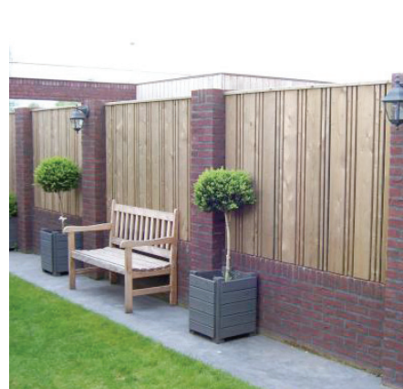
Vuren geïmpregneerd 17-planks extra gemonteerd tussen penanten 2.00 m hoog met afdeklát
