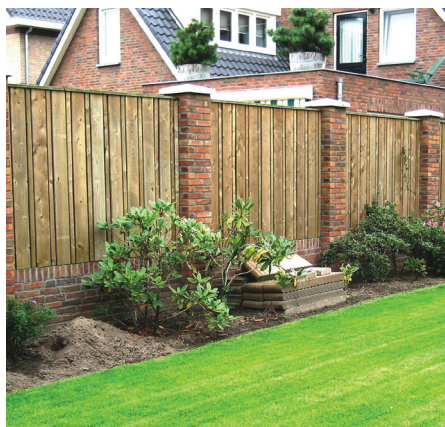
Vuren geïmpregneerd 19-planks extra gemonteerd tussen penanten 2.00 m hoog met afdeklát
