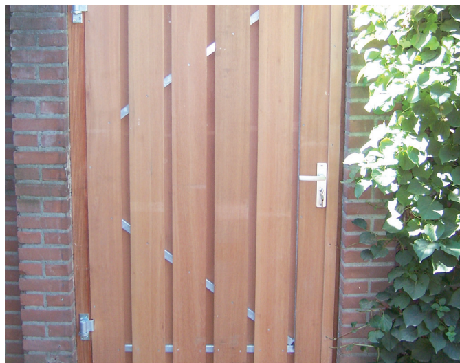
Enkele poort op frame. Hardhouten planken 2.00 hoog
