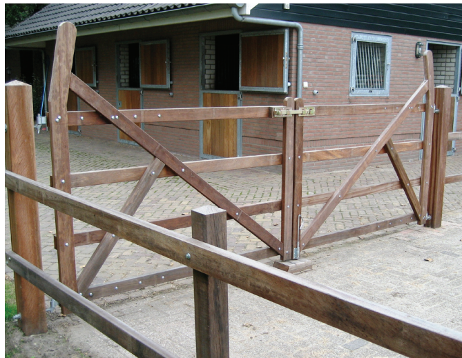
Hardhouten Engelse poort. Hardhouten palen 150 x 150 mm 1.40 hoog
